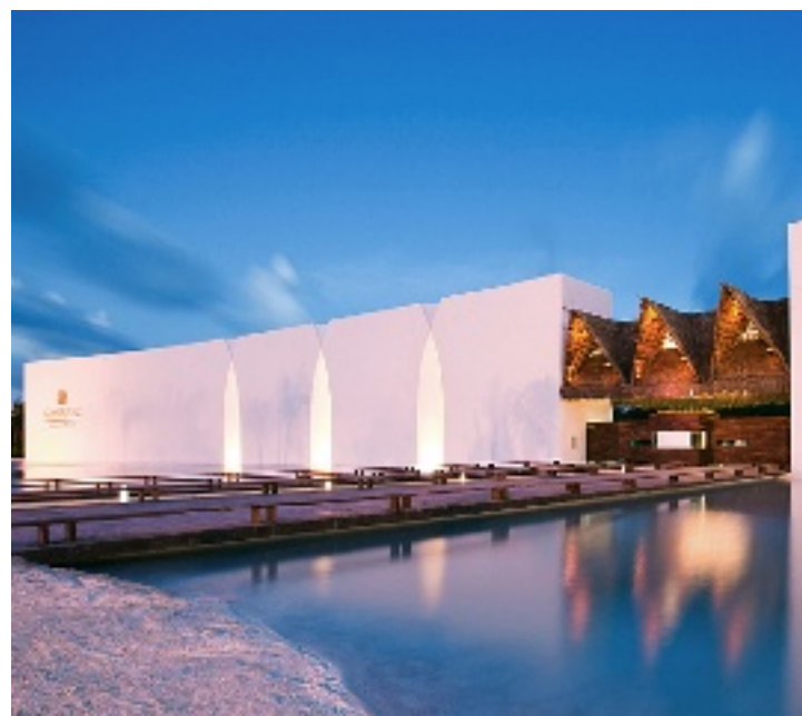
La arquitectura de Grand Velas Riviera Maya resalta en el mar Caribe.
